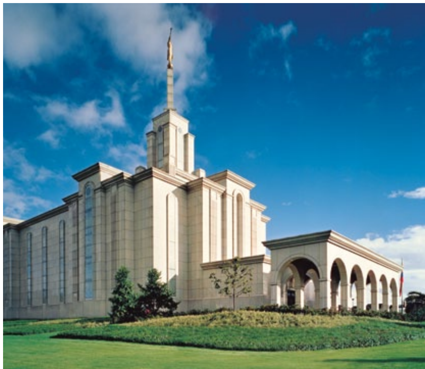
Prostředky z desátku se používají ke stavbě a k provozu chrámů.
