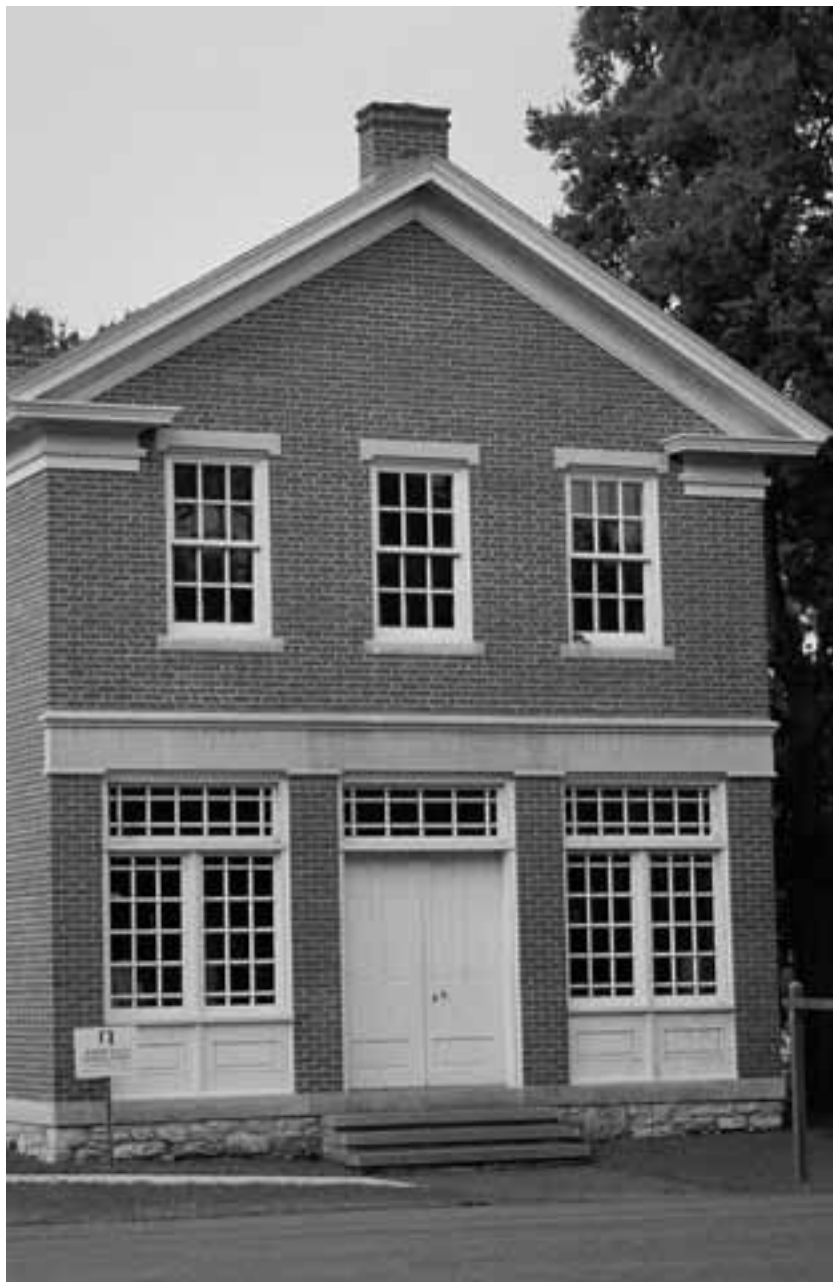
“Магазин из красного кирпича” в Наву после реконструкции. Это здание служило офисом для Пророка Джозефа Смита, а также предприятием, помогавшим ему обеспечивать свою семью. В помещениях этого магазина состоялось много церковных собраний и мероприятий с участием жителей города.
