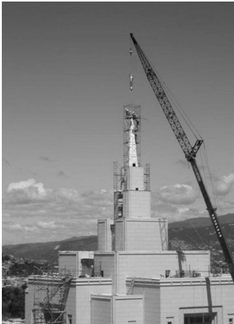
El Templo de Honduras está siendo construido en Tegucigalpa, Francisco Morazán, Honduras.
