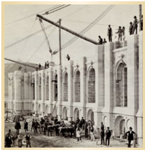
Будівництво Солт-Лейкського храму, 1877 р.
